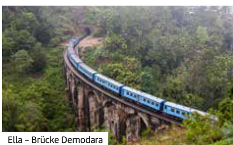
Ella – Brücke Demodara
